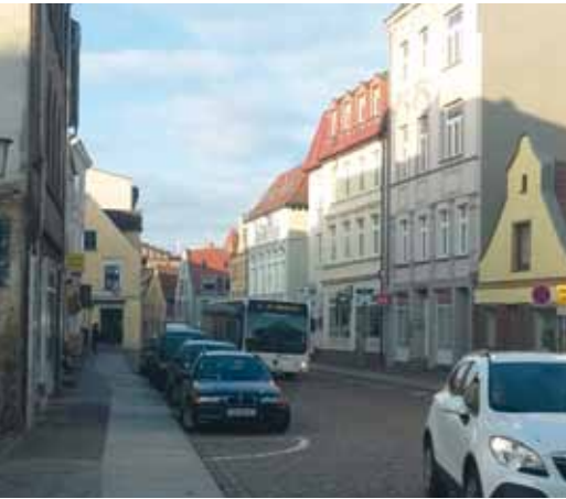
Altstadt Stralsund – Wasserstraße/Ecke Langenstraße
