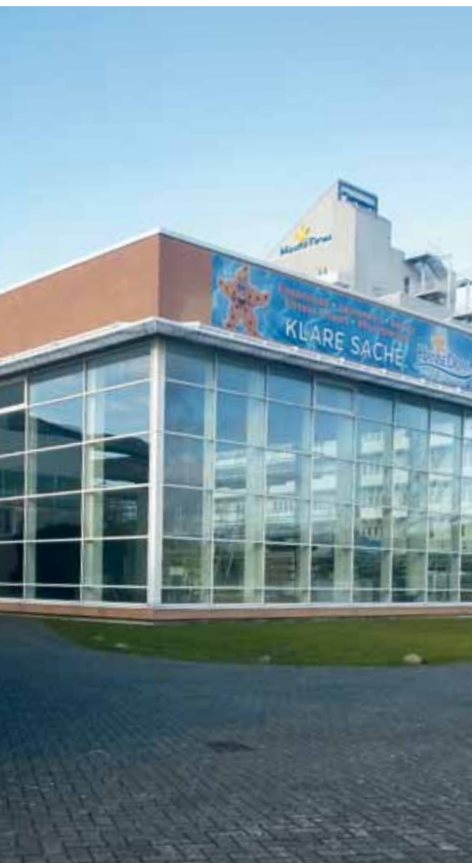
▲ Schwimmhalle Hanse Dom
